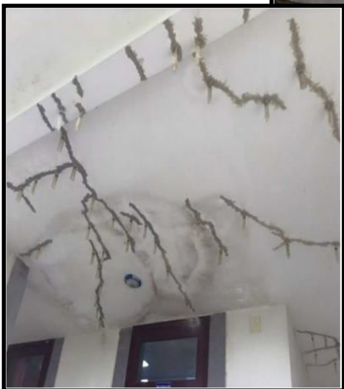
Công trình chống thấm ngược trần nhà
