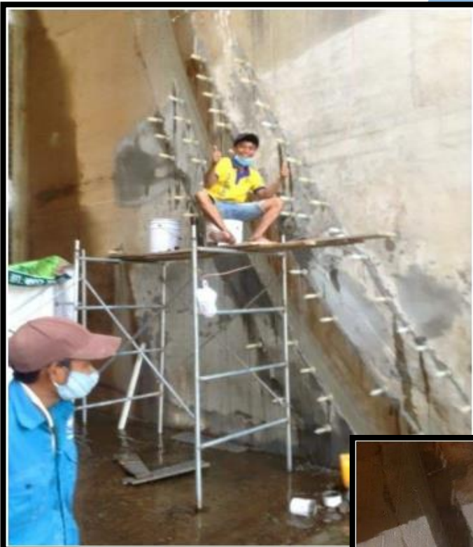
Công trình chống thấm thủy điện Rào Quán sau khi sửa chữa hoàn thiện - Tỉnh Quảng Trị
